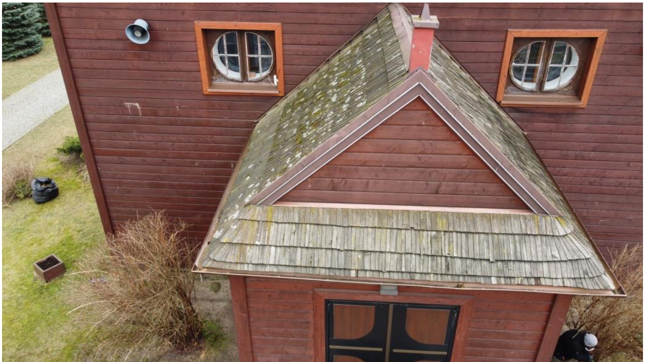
Zdjęcie nr 3 – Widok dachu kruchty od frontu
