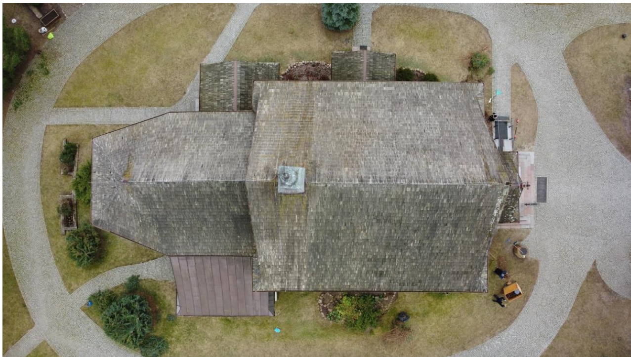
Zdjęcie nr 1 - Widok z góry dachu kościoła
