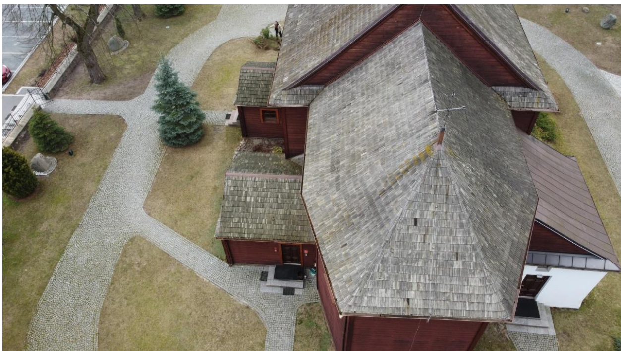
Zdjęcie nr 11– Widok dachu kościoła od strony wschodniej
