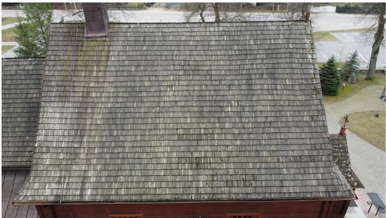
Zdjęcie nr 5, 6, 7 – Widok dachu kościoła od strony północnej
