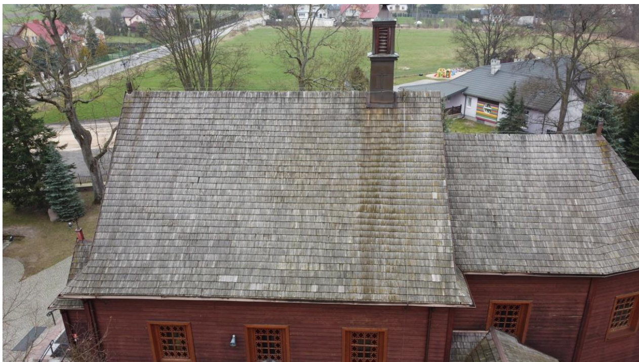
Zdjęcie nr 8,9,10 – Widok dachu kościoła od strony południowej
